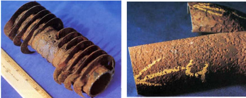
Şekil 14. Sülfürik Asit Korozyonuna Uğrayan Boru Örnekleri [7]
